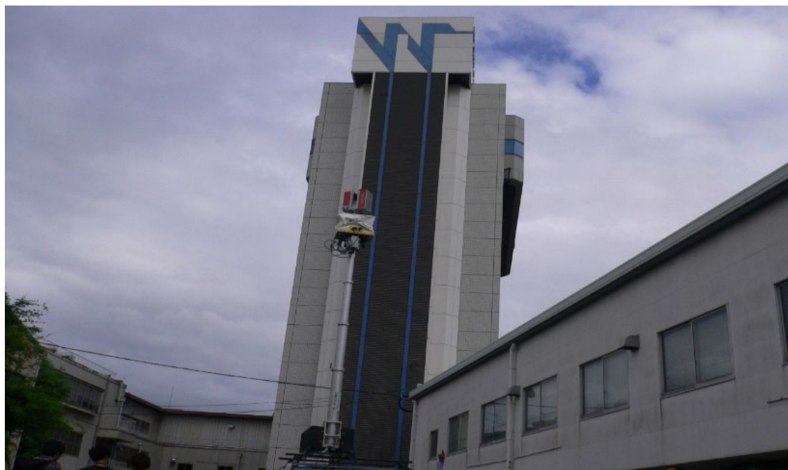
図 3.2-1 計測現場の概観
