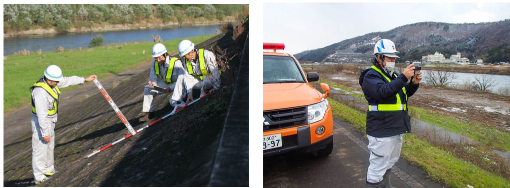
図2.1-7 目視点検の状況
