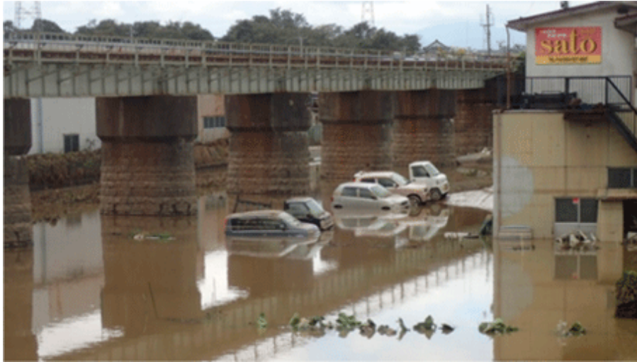
図 2.6-2 東日本台風による郡山市の浸水被害 出典：内閣府 令和2年版防災白書 21)
