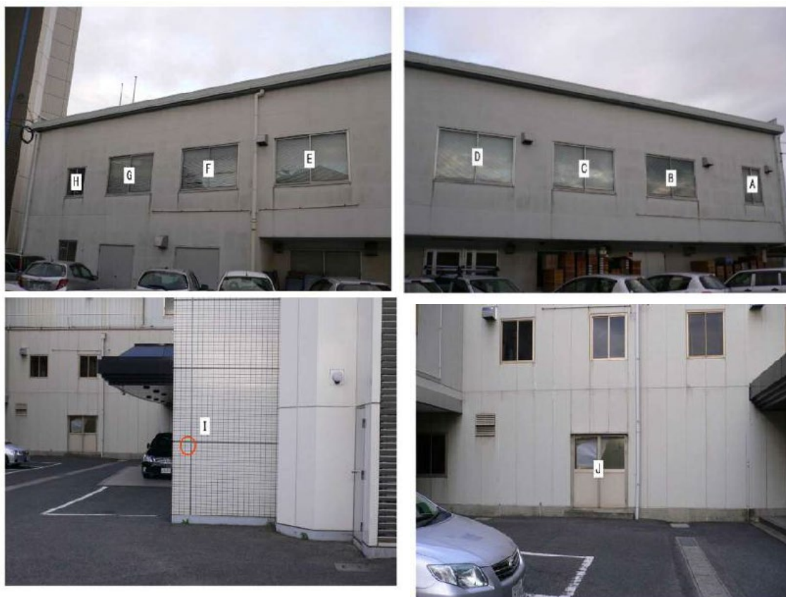
図 3.2-3 遠景写真 A~J
