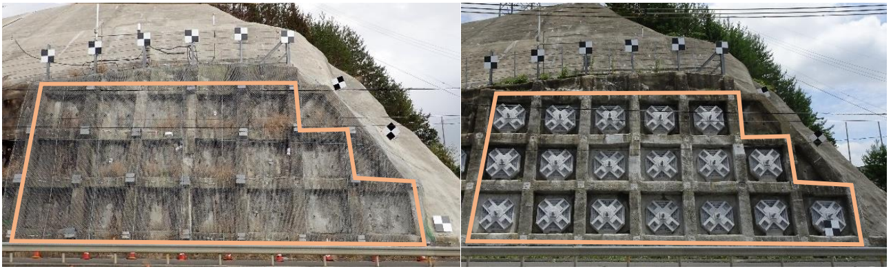
図-5.12 のり枠内アンカー新設部の1時期目から3時期目への変化
