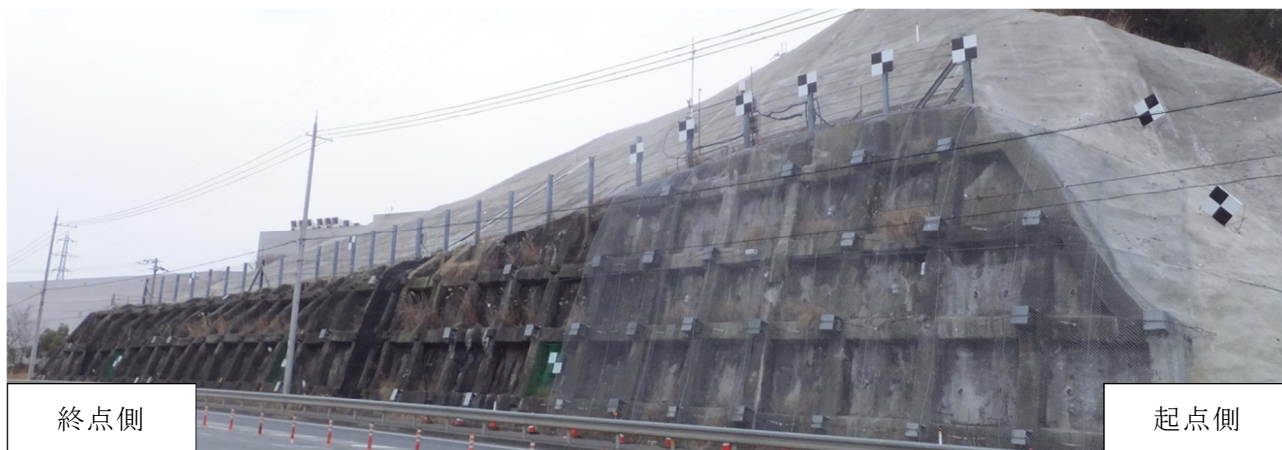
図- 2.9 計測対象としたのり枠付きのり面
