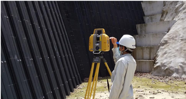
図- 1.6 固定式レーザスキャナを用いて点群を取得している様子（参考：株式会社山陽測器）
