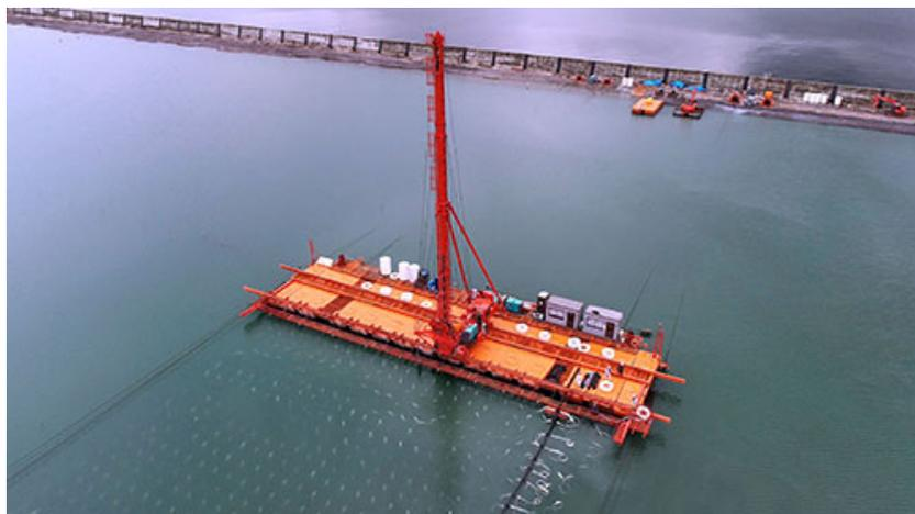
図-1.9 PDF 工法による減容化の様子(水島港玉島地区ハーバーアイランド浚渫土砂処分場)
