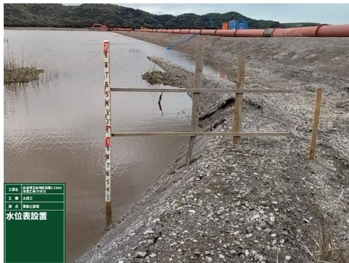
図-1.8 水位計によるモニタリング手法
