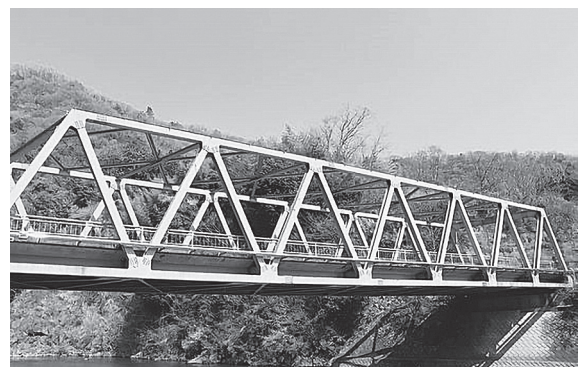
図3 トラス構造の鉄橋
