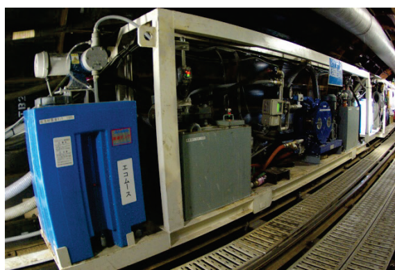
写真-2.8 気泡注入設備（坑内）
