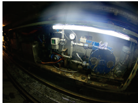
写真-2.5 気泡注入設備（坑内）
