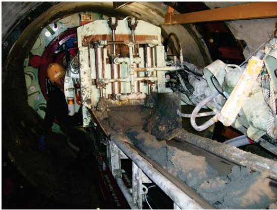
写真-2.4 排土状況（切羽）
