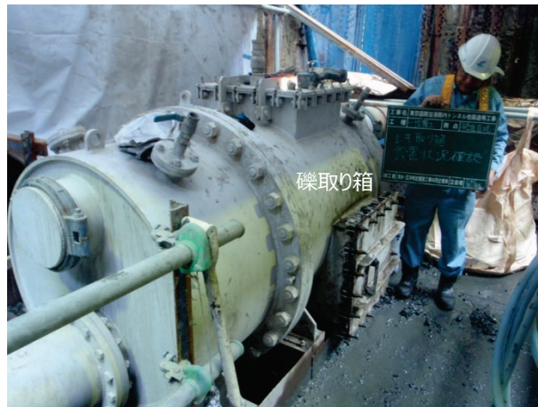
写真-5.13 礫取り箱設置状況
