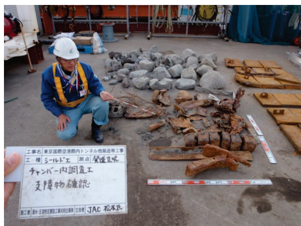
写真-5.19 回収された支障物の一部
