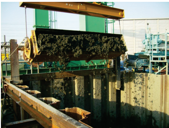
写真-2.6 排土状況（地上土砂ピット）
