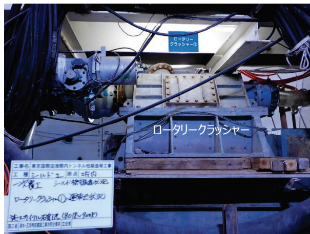
写真-5.14 ロータリークラッシャー設置状況
