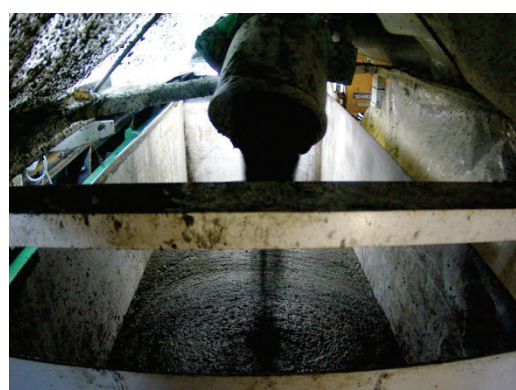
写真-2.9 排土状況（坑内）
