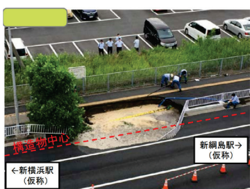
写真-1.3 道路陥没状況(2) 8)
