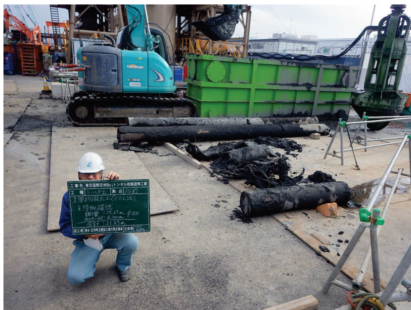
写真-5.21 支障物撤去状況
