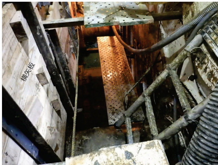
写真-5.16 チャンバー内作業状況
