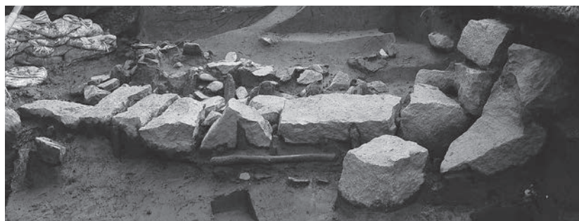
b. 南護岸 (北から)
