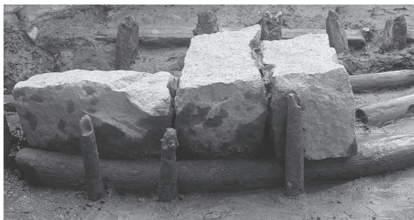
d. 南護岸胴木・杭検出状況 (北から)
