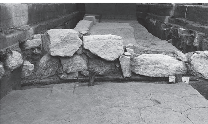
e. 西端石垣立面 (北から)
