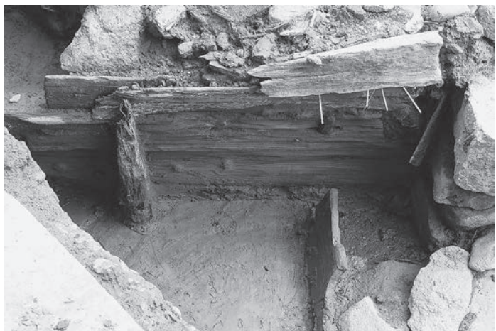
b. 上流側樋門南側護岸 (北から)
