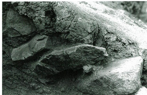
2. 後円部東トレンチ 後円部2段目斜面葺石断面
