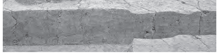
4. 溝3・5断面 (東から)
