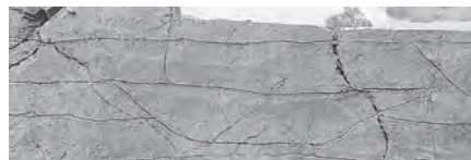
10. 溝11断面 (西から)
