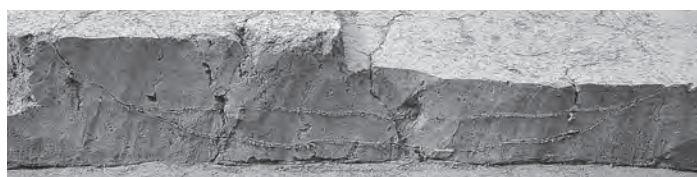
5. 溝23断面 (北から)
