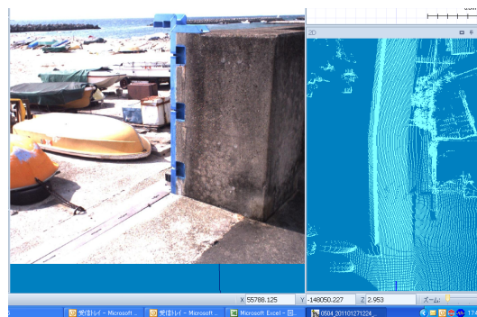
図 20 陸閘の扉体付近のデジタル画像
