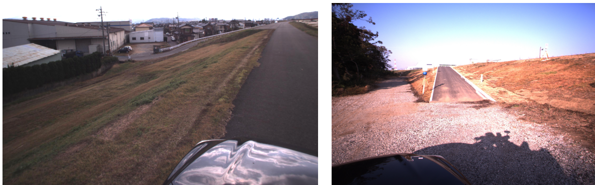
図 5(1) デジタル画像例 (左：堤防天端からの撮影、右：堤防法尻からの撮影)
