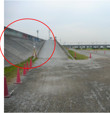
図 16(1) 高潮堤防 法尻走行時のデジタル画像
