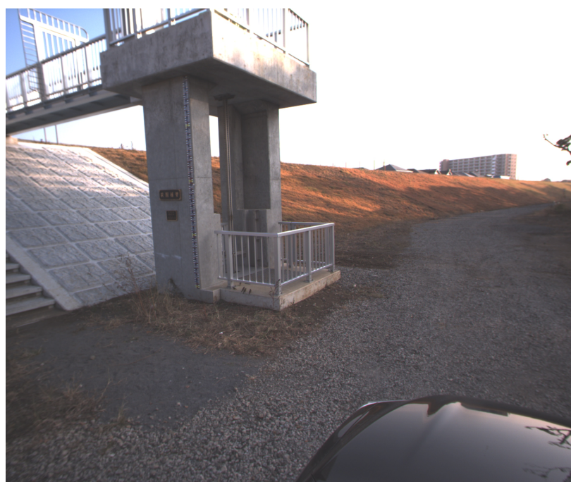
図 22(1) 樋門部周辺のデジタル画像
