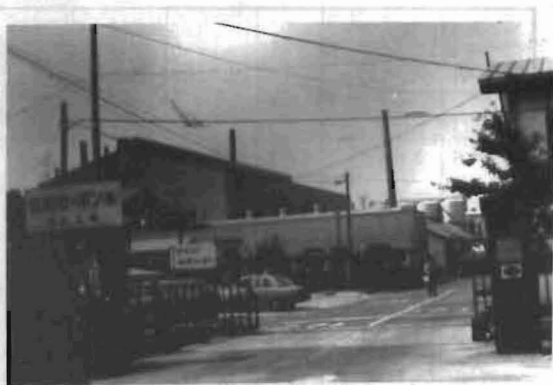
写真4-5-10 協和カーボン株式会社岡山工場
