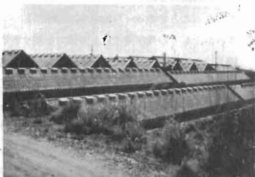
写真7-2-4 吉備高原上に建設された大規模な温室
