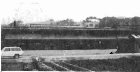
写真7-4-1 角南かんづめ製造所 昭和45年4月撮影
