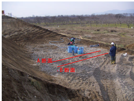
写真 6.1 実験現場の状況
