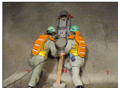
探査機設置状況
