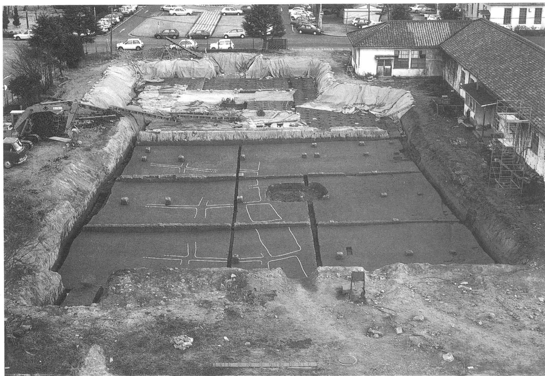
2 8層上面西半部弥生時代水田検出状況（西から）
