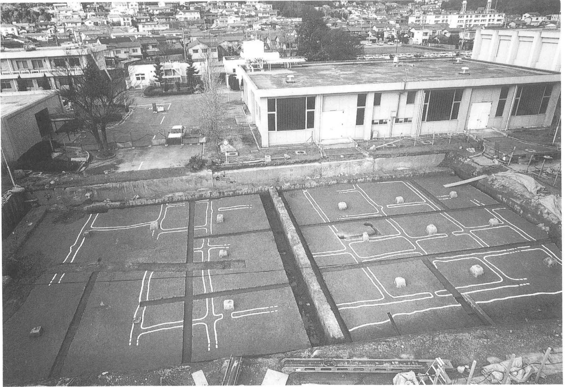
1 9層上面水田遺構検出状況（南から）
