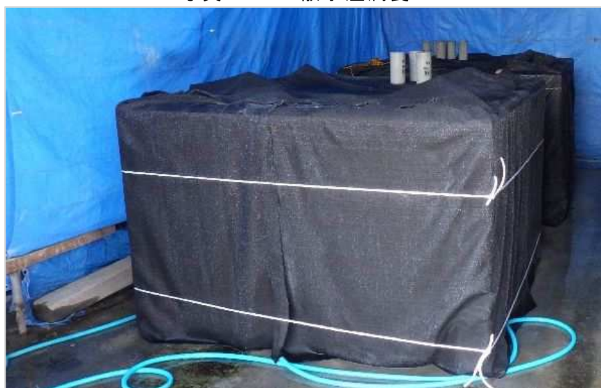
写真 4.3-1 散水湿潤養生
