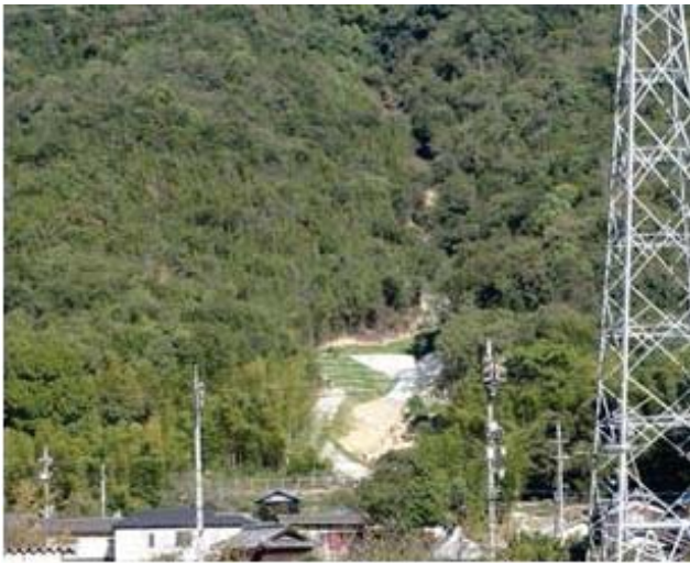
写真.1 崩壊地の全景
